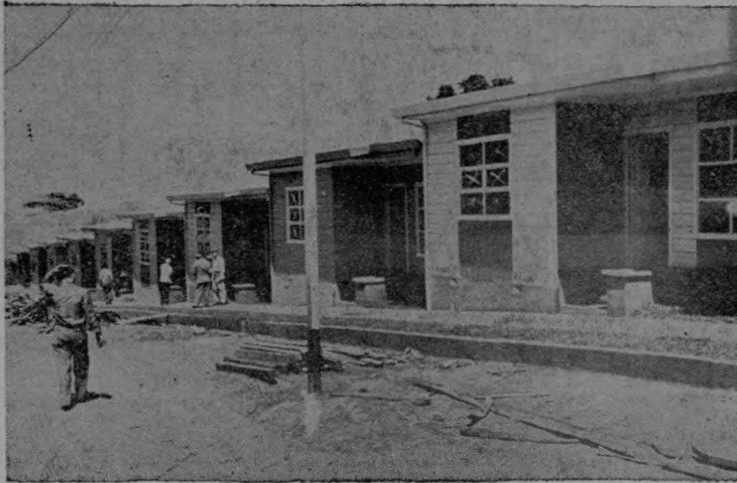
Las nuevas casas que de acuerdo con el plan de renovación se están construyendo
